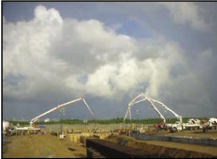
Figura 20. Colado de Cabeceral.
