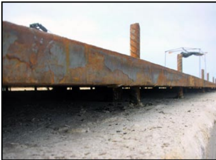
Figura 21. Colocación y nivelación de placas metálicas como superficie de rodamiento.
