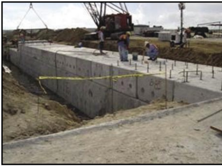
Figura 19. Colocación de bloques en Correderas B.
