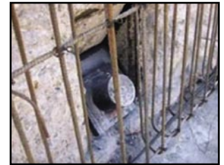
Figura 17a. Cabeza de anclaje protegida en segunda etapa de colado de la trabe de coronamiento.
