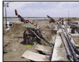
Figura 17. Perforación y equipamiento de anclas.
