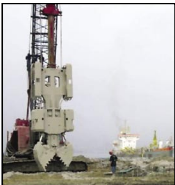
Figura 16. Excavación de Muro Milán con almeja hidráulica.
