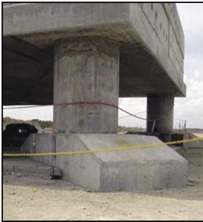
Figura 15. Asentamiento en las zapatas perimetrales durante la prueba de carga para inclusiones a 33 Ton/m 2
