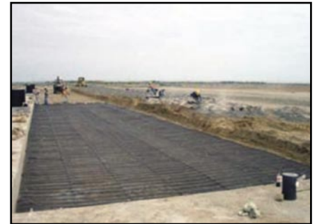
Figura 18. Construcción de capa de suelo: cemento.
