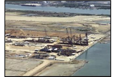
Figura 4. Vista del patio Octubre 2008. Se ven sobre las dos Correderas las plataformas que actualmente están en fabricación.
