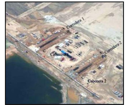
Figura 3. Vista aérea del patio, con los 300 m de frente de agua, las Correderas 1 y 2, las traveses A, B y C y las Cabeceras 1 y 2. Etapa en Obra.
