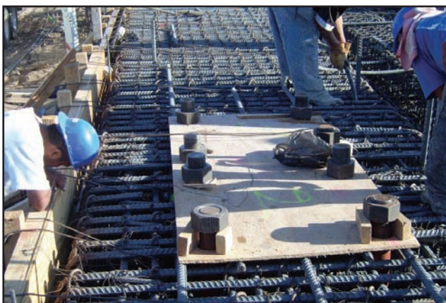
Foto 11. Colocación y fijación de anclas de Bitas en Muro Cantil.
