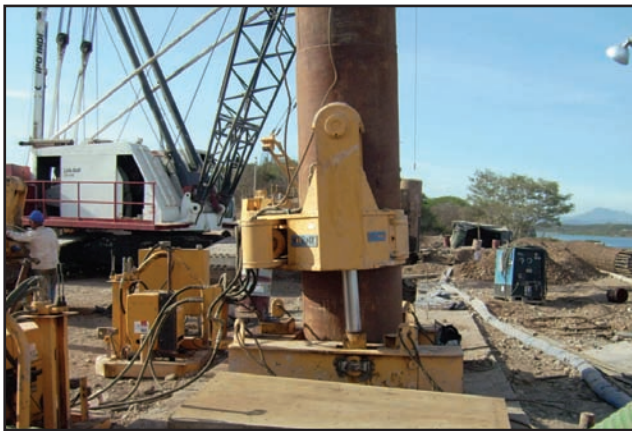
Foto 9. Extracción de juntas metálicas con gato hidráulico a Muro Milán.
