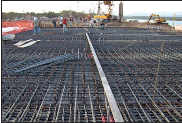
Foto 10. Armado de losa.
