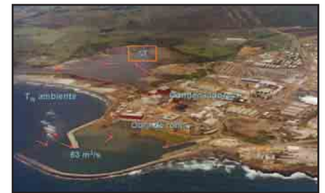
Figura 1.- Sistema de enfriamiento de la CNLV
